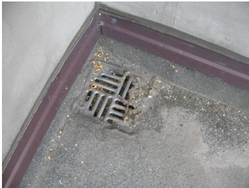
Zdj. nr 2. Istniejące odwodnienie balkonu – widok jednej z dwóch kratki odwadniających przeznaczonych do przebudowy wraz z ich wymianą
