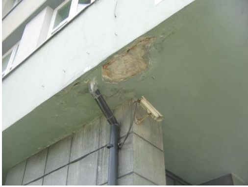
Zdj. nr 1. Zawilgocony i odpadający tynk balkonu
