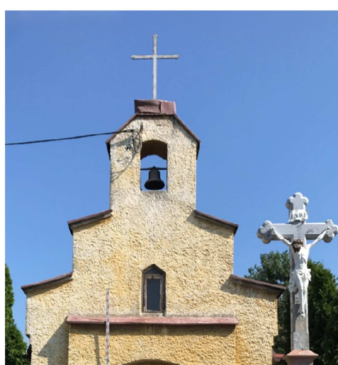
Fot. 6 Wykończenie ściany frontowej z ramą, wnęką i attyki dachu wraz z sygnaturką i krzyżem
