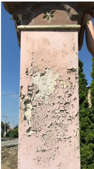
Fot.25 Ubytki na figurze Krzyża kamiennego przydrożnego
