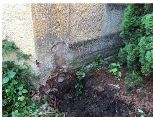
Fot. 4 Ubytki w tynku i korozja biologiczna na elewacji zachodniej – miejsce połączenia z ogrodzeniem
