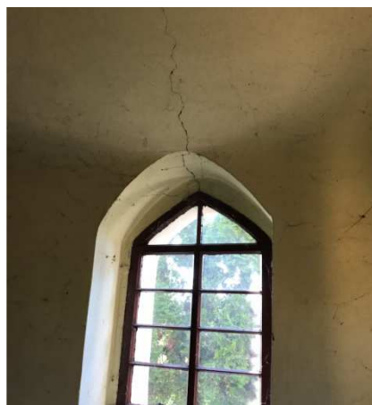
Fot. 8 Pęknięcie nad oknem oraz na sklepieniu od strony wschodniej
