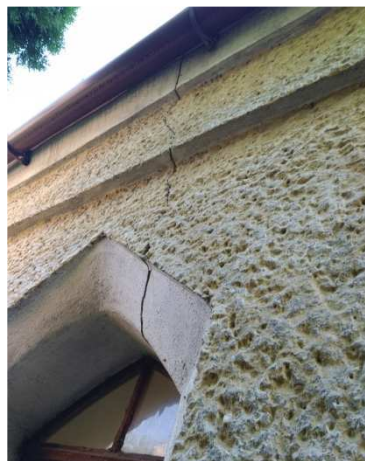
Fot. 10 Pęknięcie nad zewnątrz od strony wschodniej
