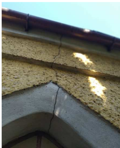
Fot. 9 Pęknięcie nad zewnątrz od strony zachodniej
