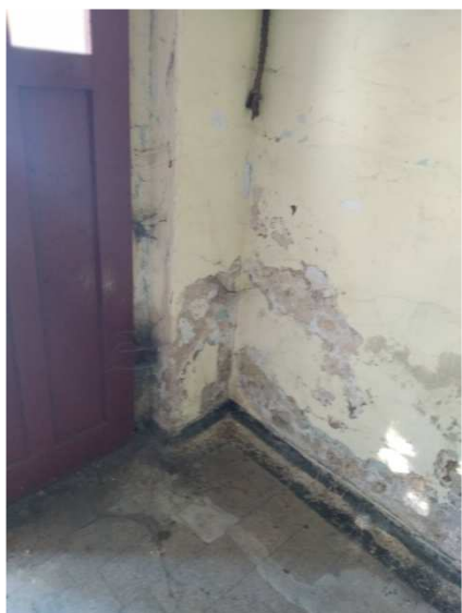
Fot. 1 Ubytki w tynku wewnątrz kaplicy
