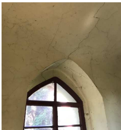
Fot. 7 Pęknięcie nad oknem oraz na sklepieniu od strony zachodniej
