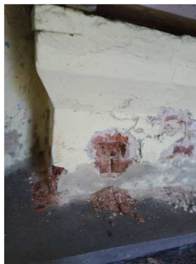
Fot. 2 Ubytki w tynku na wymurowanym ołtarzu
