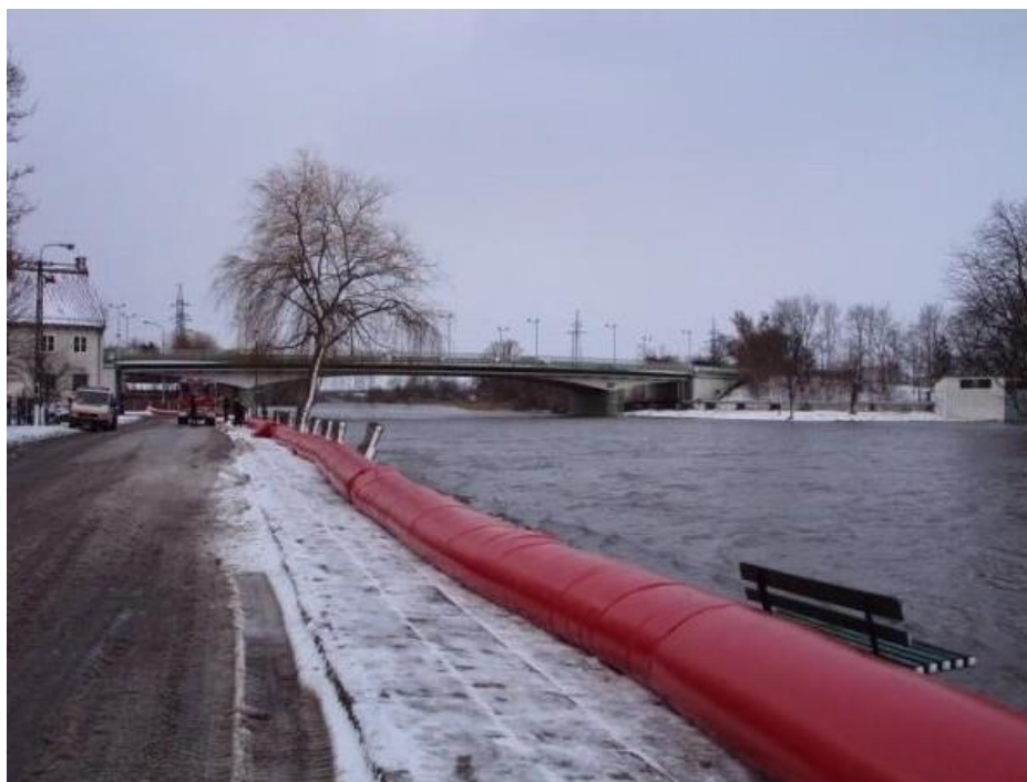
Fotografia 3: Zapory przeciwpowodziowe napełniane wodą.
