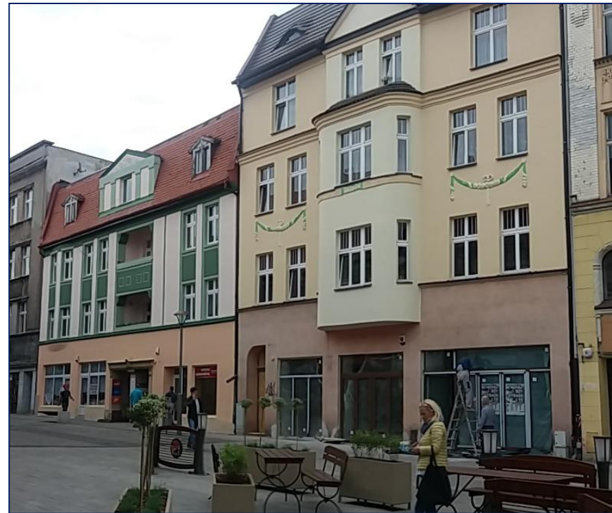
Nr 20 i 22 – nowa elewacja kamienic
