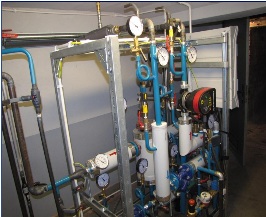
Nr 20 - stacja wymienników ciepła
