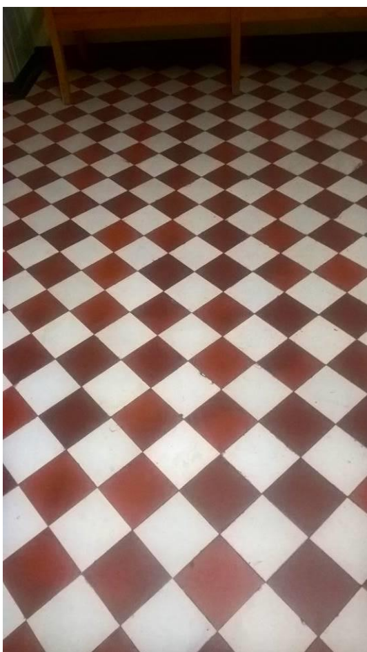
Fot.5 Płytki cementowe 15x15cm istniejące
