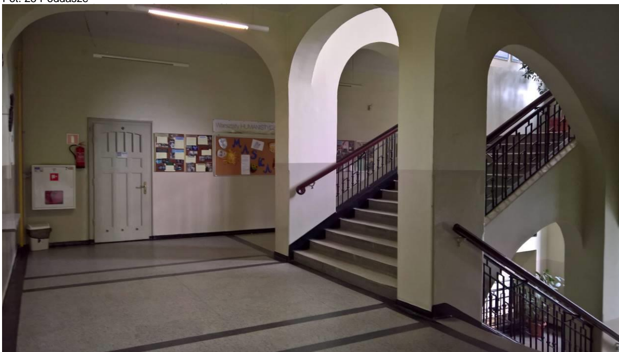
Fot. 26 Klatka schodowa główna – okładzina schodów do wymiany
