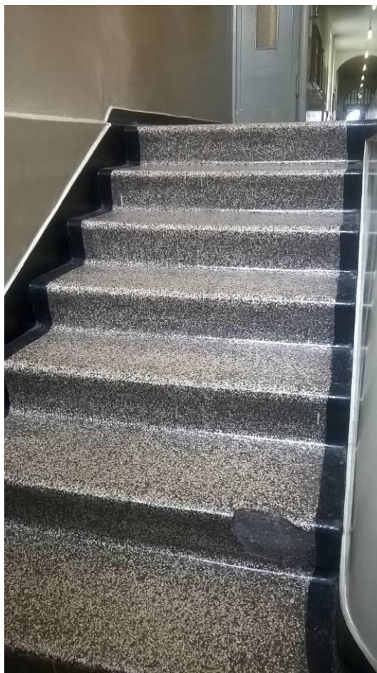
Fot. 27 i 28 Klatka schodowa boczna i przy sali gimnastycznej – okładzina schodów do wymiany
