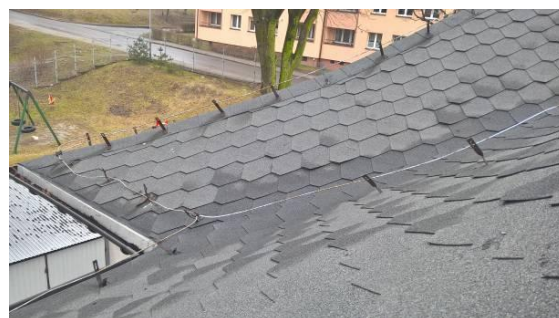
Zdj. nr 12 Instalacja odgromowa do wymiany
