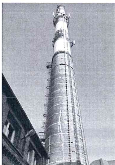
Widok obiektu wraz z zainstalowanym zespołem antenowym
