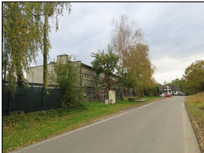
Fot. 1 Część północno-zachodnia, dojazd do RSK i GPZON
