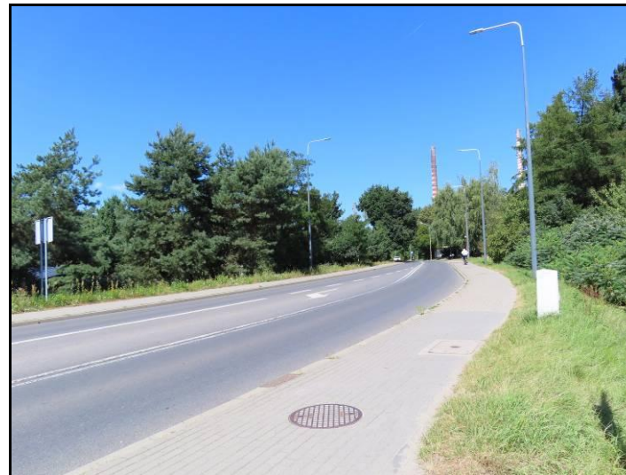
Fot. 11 Ul. Podmiejska
