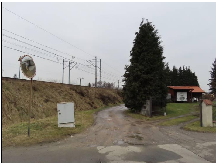
Fot. 5 Teren nr 2, nasyp kolejowy po południowej stronie terenu
