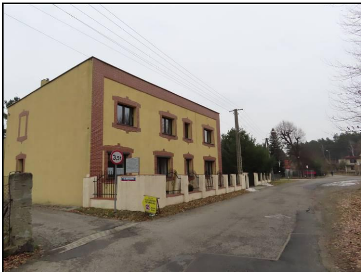
Fot. 9 Teren nr 4, połączenie ul. Stalowej i ul. ks. E. Szramka
