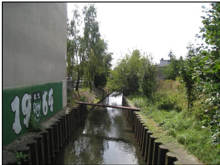
Fot. 5 Rzeka Nacyna z mostu na ul. J. Hallera
