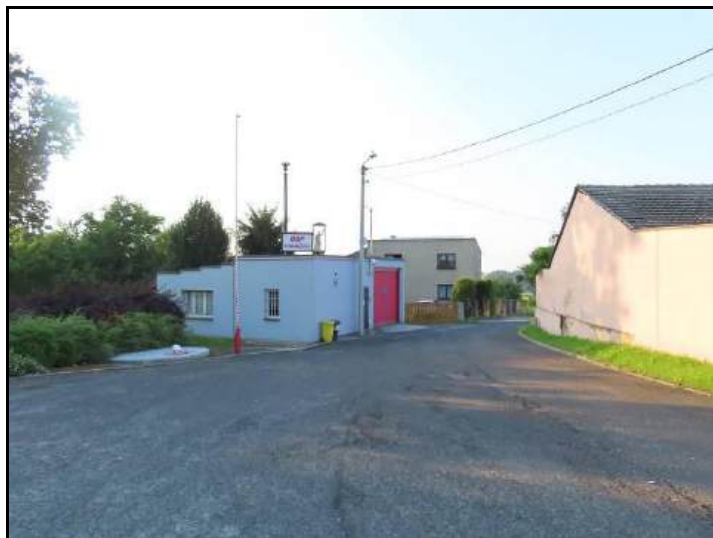
Fot. 21 Teren nr 5, remiza w rejonie ul. Wiosennej
