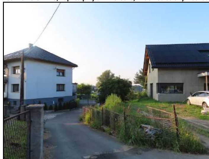
Fot. 24 Zabudowa w północnej części terenu nr 5
