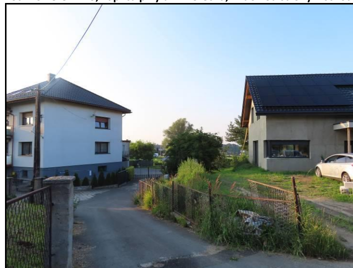
Fot. 24 Zabudowa w północnej części terenu nr 5
