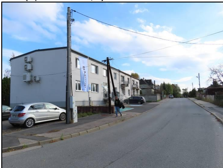
Fot. 2 Ul. Jankowicka, widok w kierunku południowym
