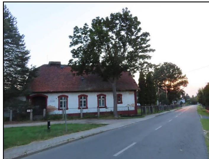
Fot. 15 Zabytkowa szkoła w Grabowni (poza analizowanym terenem)
