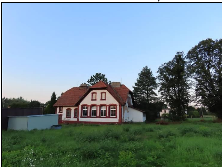
Fot. 14 Zabytkowa szkoła w Grabowni (poza analizowanym terenem)
