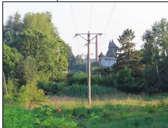
Fot. 24 Widok z ul. Ludowej wzdłuż linii średniego napięcia na kościół i dawną cegielnię w Wielopolu
