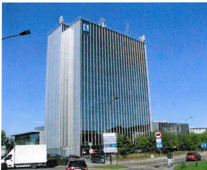
Zał. nr 1: Widok ogólny instalacji radiokomunikacyjnej.
