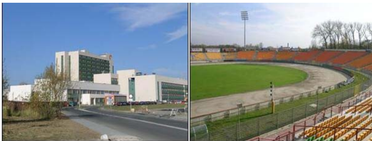
Fot. nr 18 i 19 - Zespoły celu publicznego o znaczeniu ponadlokalnym: Szpital Wojewódzki w dzielnicy Orzepowice, Stadion Miejski przy ulicy Gliwickiej
