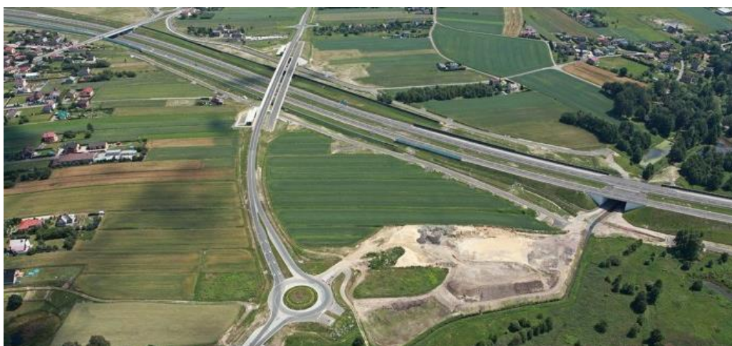
Rysunek 2-4 Droga Regionalna Racibórz-Pszczyna w okolicach przecięcia z A1. Na fotografii widać rezerwę pod przekrój 2x2 (dwa wiadukty nad A1) oraz rondo do którego będzie włączona obwodnica Rybnika
