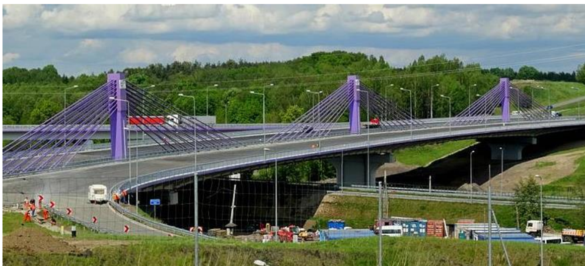
Rysunek 2-2 Most autostradowy w ciągu A1 w gminie Mszana
