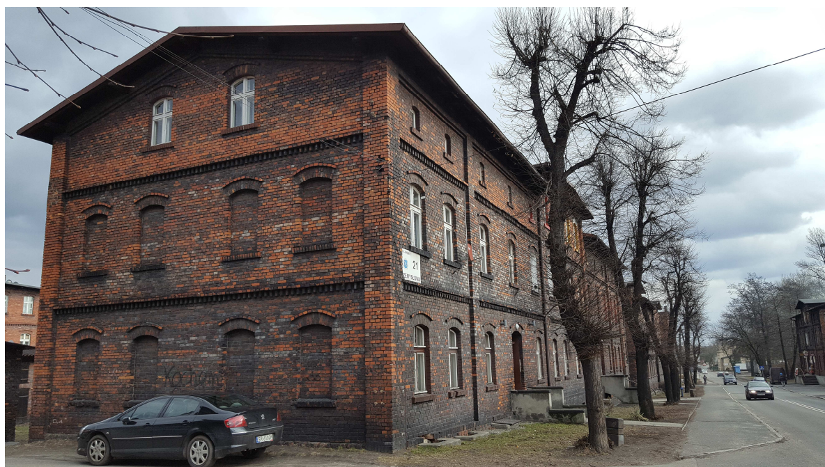
Zdjęcie 5. Budynki socjalne przy ul. Przemysłowej.
