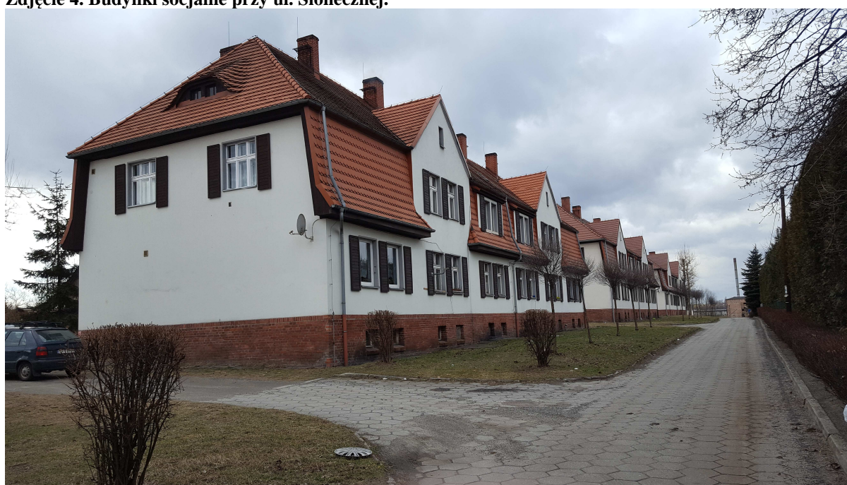
Zdjęcie 4. Budynki socjalne przy ul. Słonecznej.
