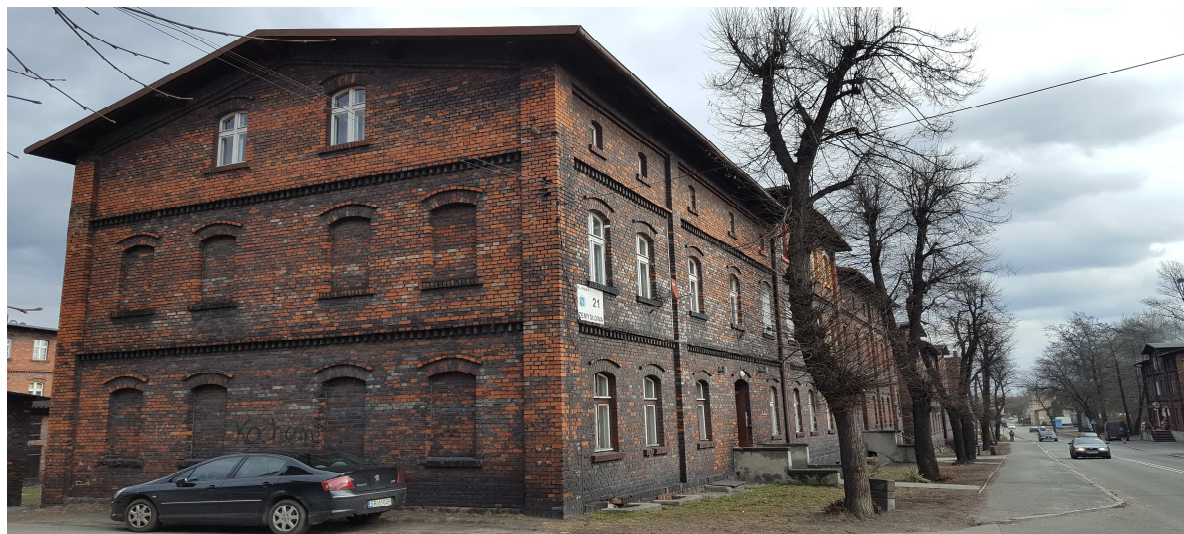
Zdjęcie 5. Budynki socjalne przy ul. Przemysłowej.
