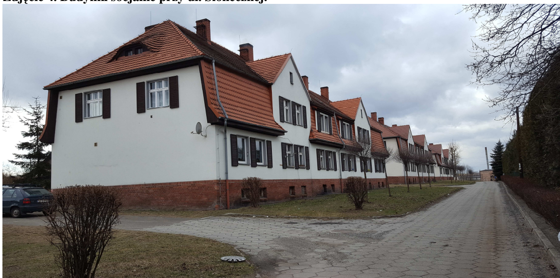
Zdjęcie 4. Budynki socjalne przy ul. Słonecznej.
