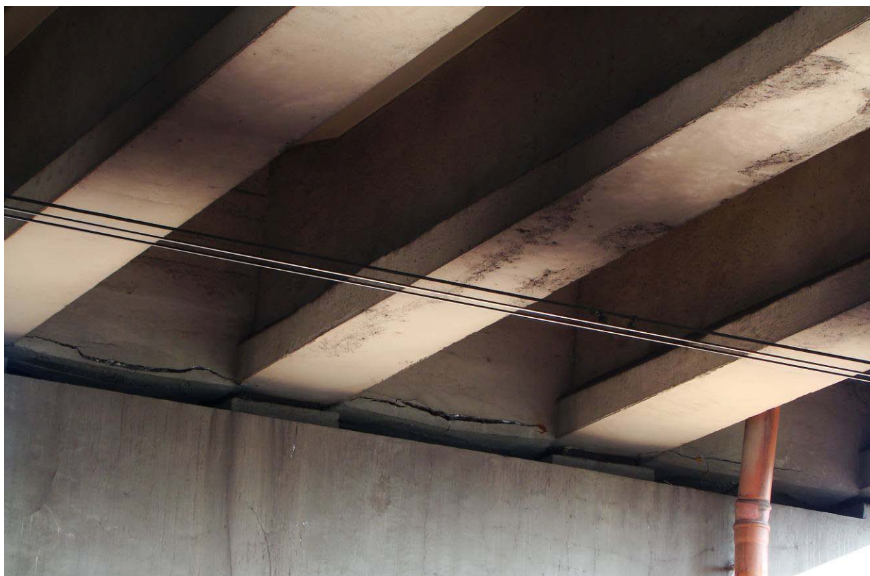
Fot. 11. Poprzecznicę nad podporą w osi 1 (od strony Centrum)
