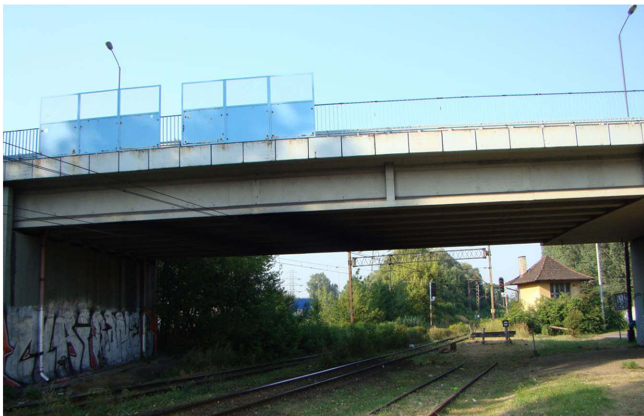
Fot. 3. Widok od strony północno-wschodniej na przęsło drugie
