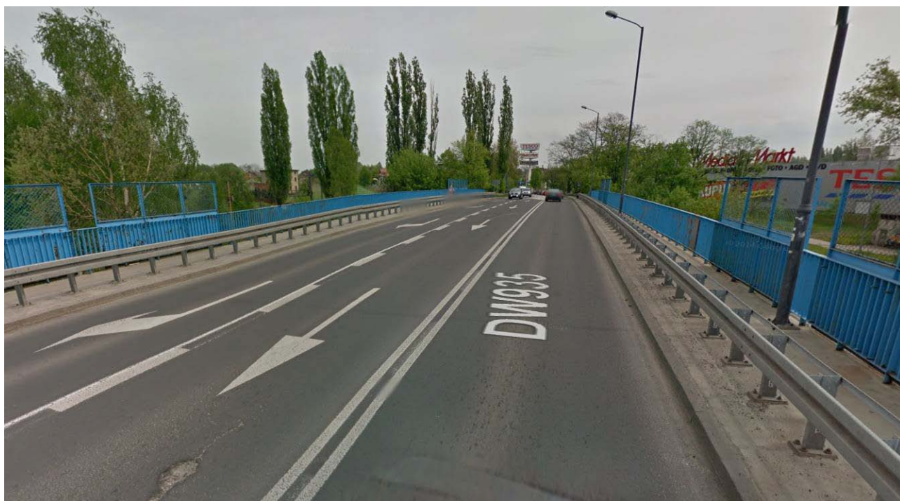
Fot. 4. Jezdnia na wiadukcie – widok w kierunku Żor
