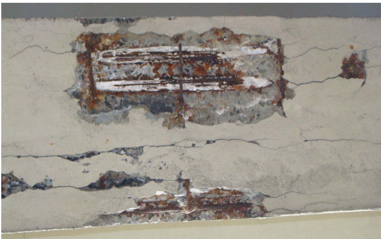
Fot. 6. Belka skrajna (nr 8) – przęsło 1 – miejsce 1 - kabel skrajny (1) i przedskrajny (4) skorodowane – iniekt utracił właściwości ochronne. Pęknięcia podłużne wskazują na korozję również pozostałych kabli.
