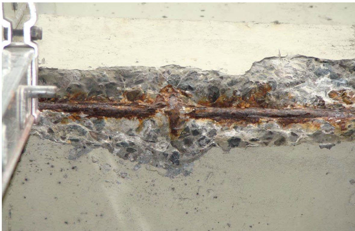
Fot. 3. Belka skrajna (nr 1) – korozja pręta zbrojeniowego spowodowała odspojenie betonu w narożu belki.
