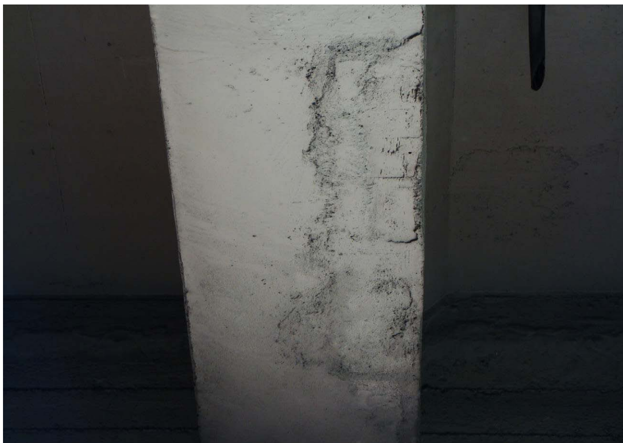
Fot. 10. Ślady po naprawach
