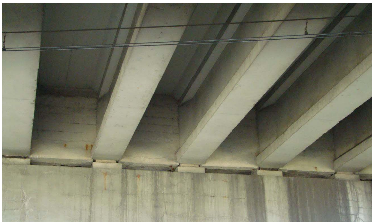
Fot. 12. Poprzecznicę nad podporą w osi 3 (od strony Żor)
