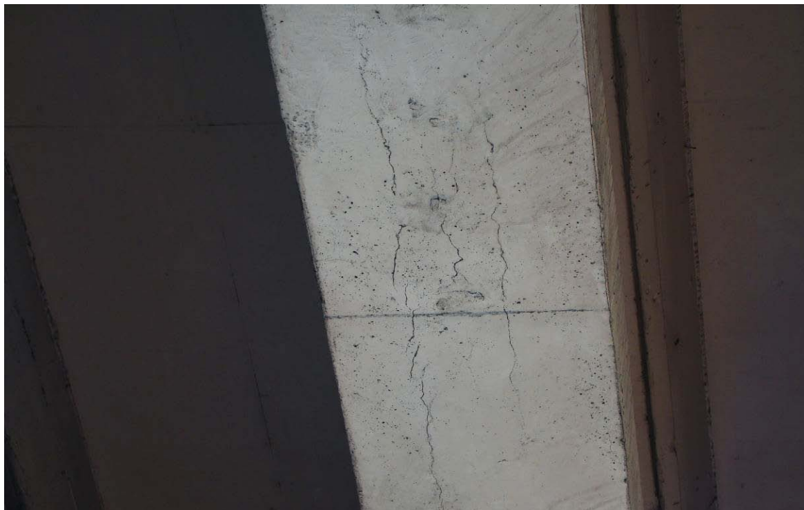
Fot. 9. Typowe pęknięcia na dźwigarach prefabrykowanych cd.
