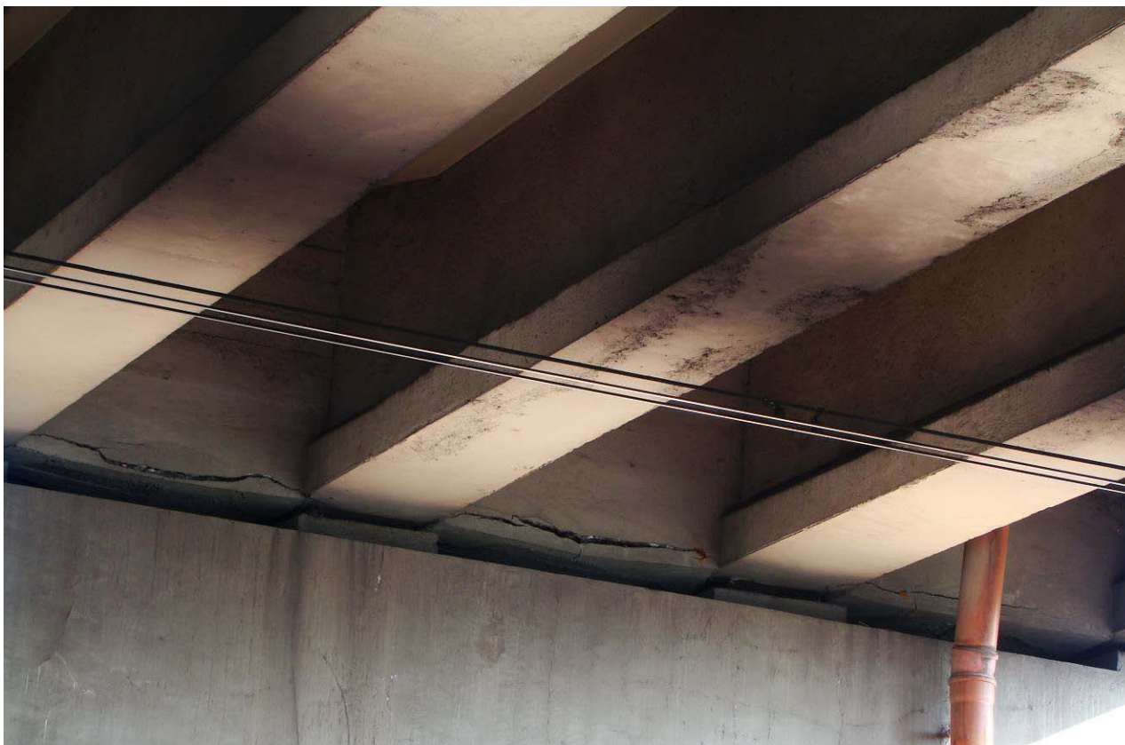
Fot. 10. Odspojenie otuliny prętów zbrojących dolną powierzchnię poprzecznic od strony Centrum.
