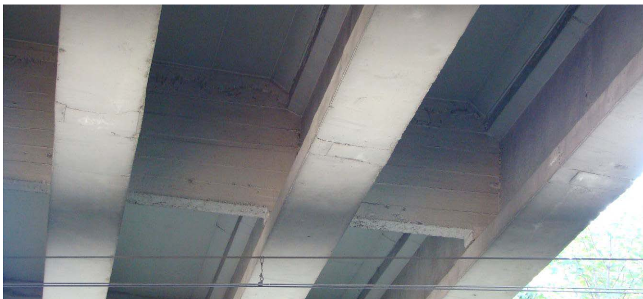
Fot. 5. Poprzecznica przedskrajna, widoczne miejsca łączenia dźwigarów głównych
