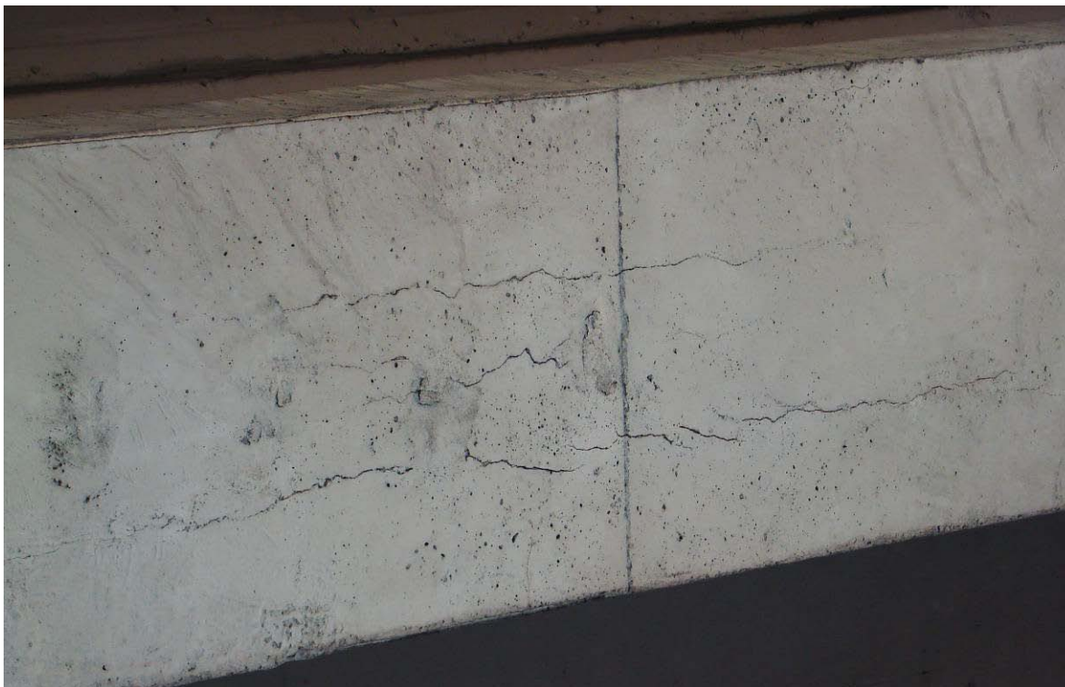
Fot. 5. Belka przedskrajna (nr 7) – pęknięcia w miejscach kabli sprężających
