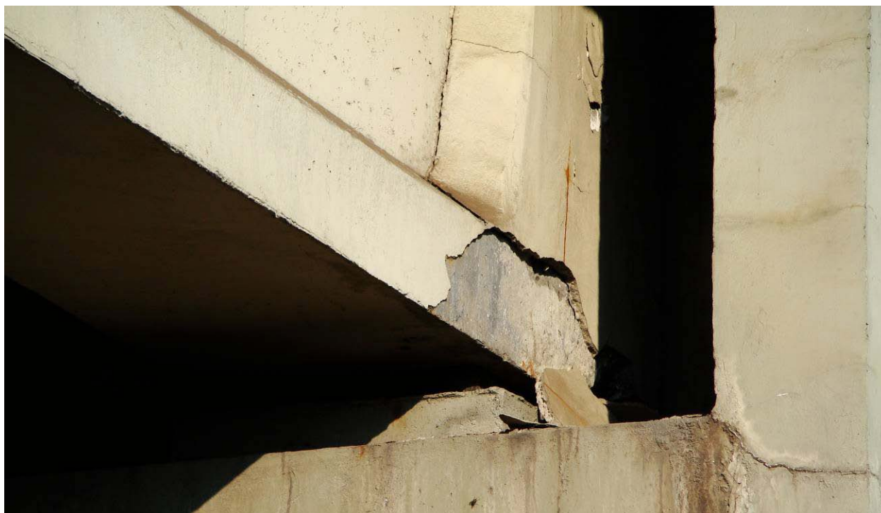
Fot. 12. Strefa podporowa dźwigara na podporze w osi 1 – koniec poprzecznicy (od strony północno – wschodniej)
