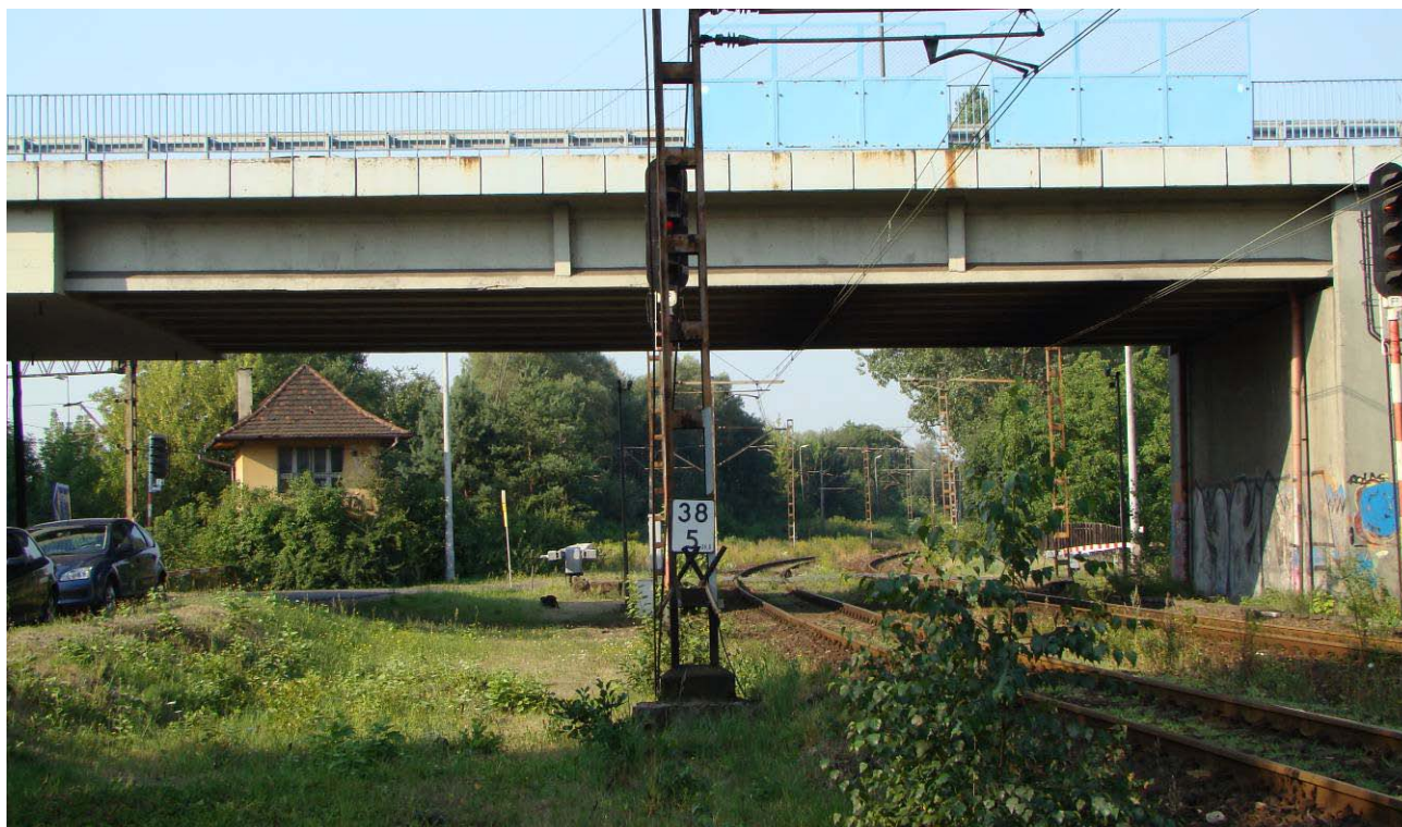
Fot. 2. Widok od strony północno-wschodniej na przęśło pierwsze
