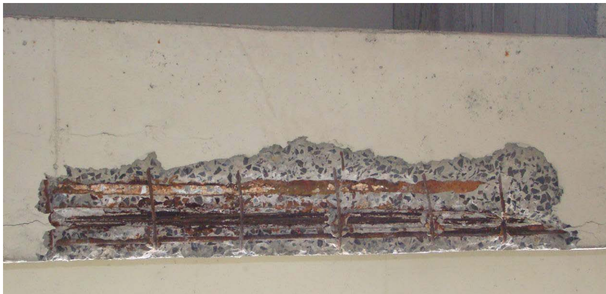
Fot. 8. Belka skrajna (nr 8) – przęsło 1 – miejsce 2 – korozja zbrojenia miękkiego i sprężającego.
