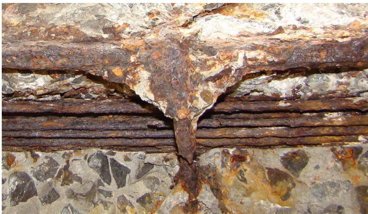
Fot. 2. Belka skrajna (nr 1) jest w stanie niedostatecznym – jw. – zbliżenie.
