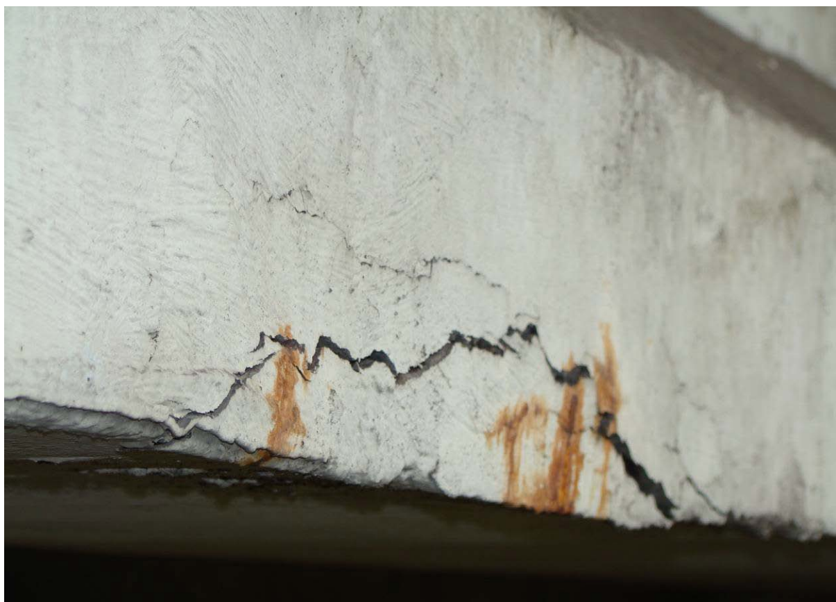
Fot. 8. Typowe pęknięcia na dźwigarach prefabrykowanych cd.
