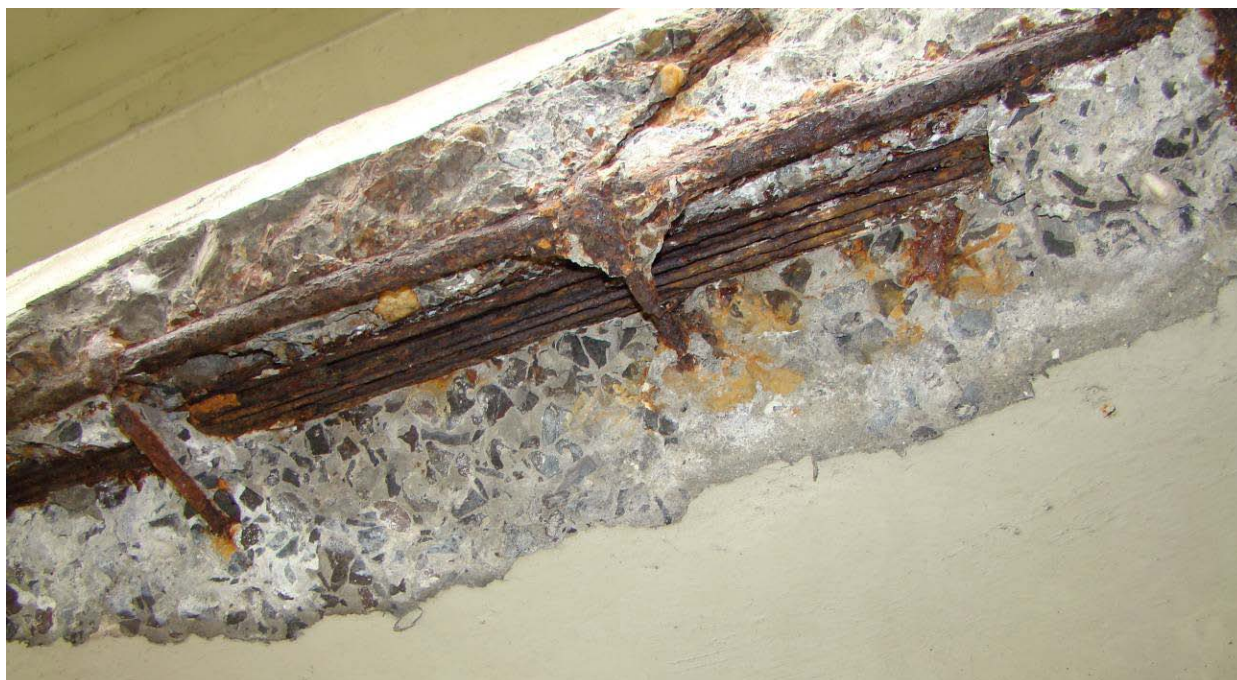
Fot. 1. Belka skrajna (nr 1) – znaczna korozja kabla sprężającego, przerwane pojedyncze druty, brak otuliny i osłonki. Korozja zbrojenia miękkiego. Przerwane strzemie.
