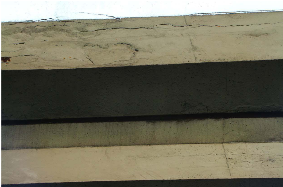
Fot. 7. Typowe pęknięcia na dźwigarach prefabrykowanych (największe na dźwigarach skrajnych)
