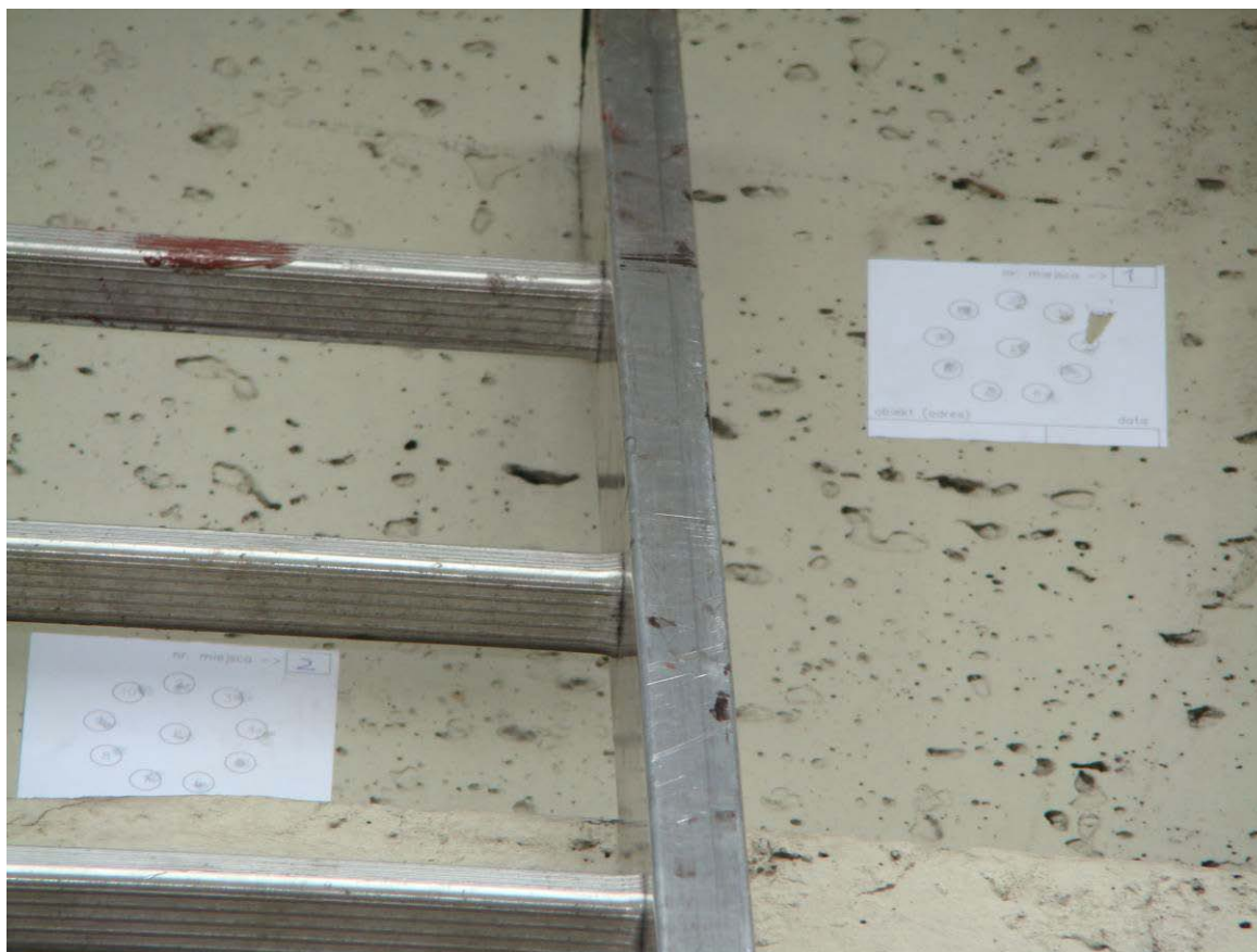
Fot. 2. Dwa punkty na środku dźwigara nr 1
