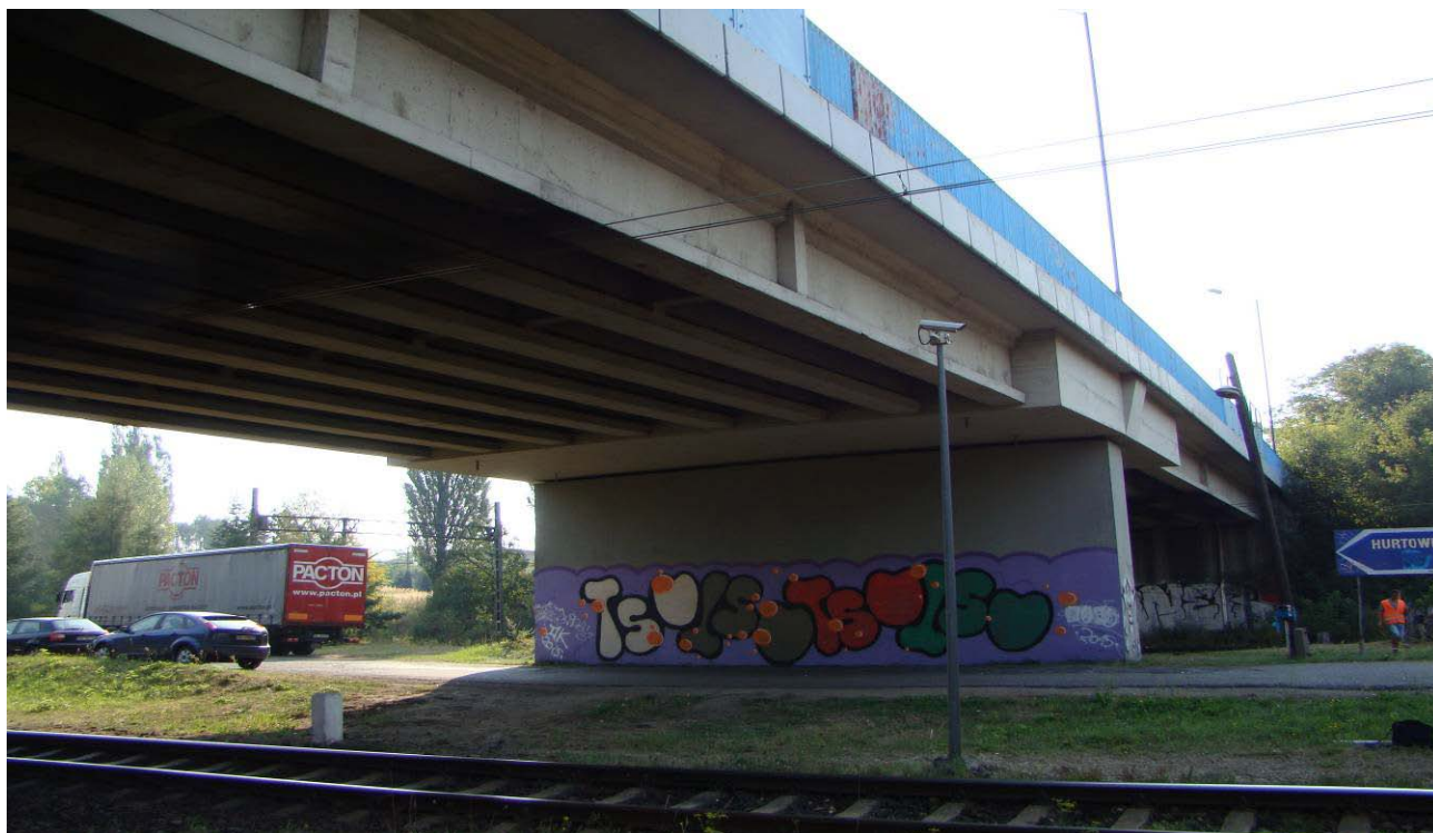
Fot. 1. Widok wiaduktu od strony południowo-zachodniej
