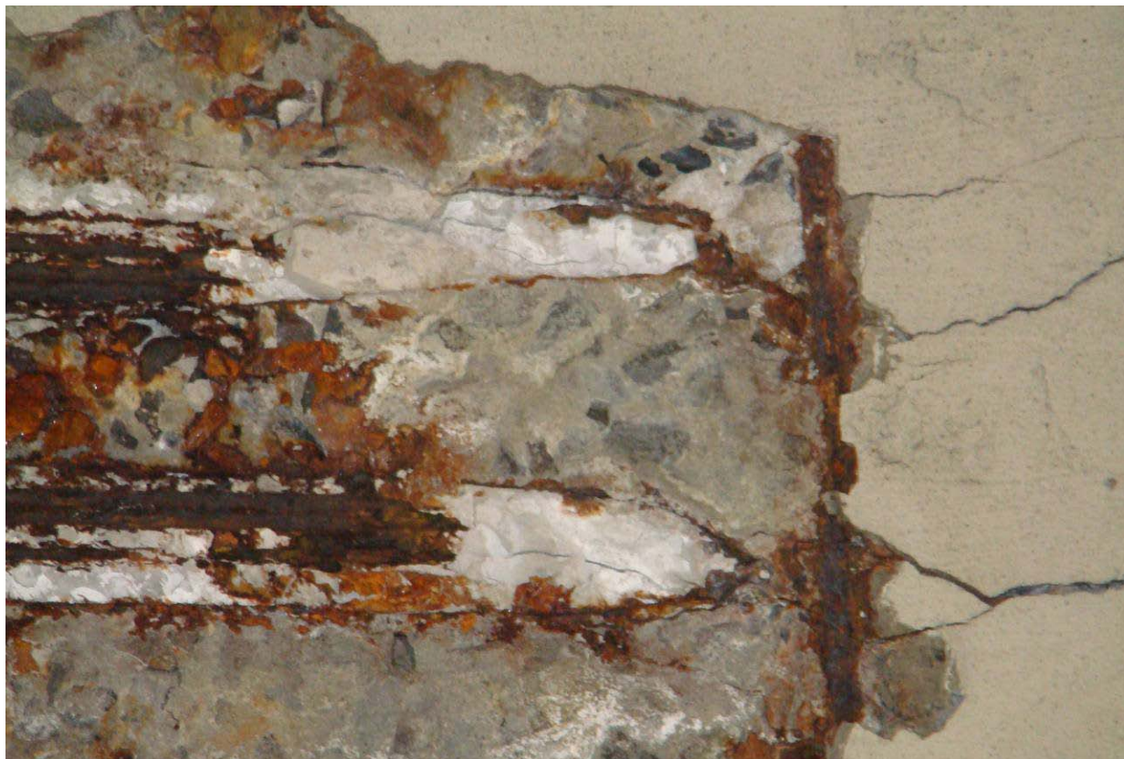
Fot. 7. Belka skrajna (nr 8) – przęsło 1 – miejsce 1 – jw. (zbliżenie) – widoczna korozja kabli
