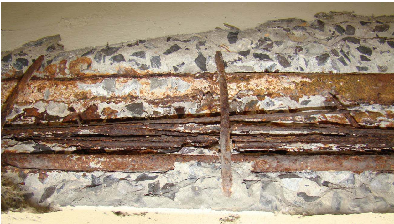
Fot. 9. Belka skrajna (nr 8) jest w stanie niedostatecznym – przęsło 1 – miejsce 2 – jw. (zbliżenie) - kabel skrajny (1) silnie skorodowany – przerwane druty. Osłonka kabla (4) całkowicie skorodowana, iniekt jednak pozostaje dalej związany z ciągnem.
